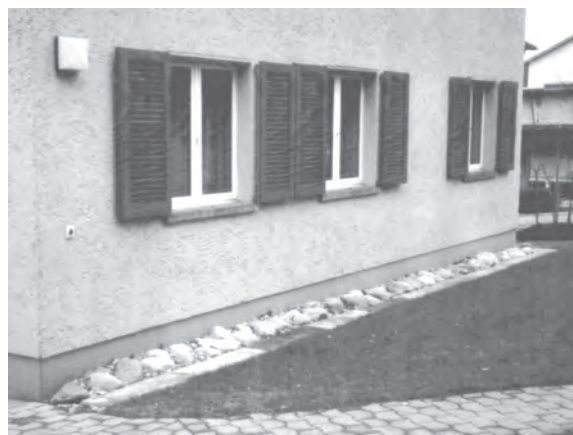
Fassadenanschlüsse: unten verbessert zur Austrocknung
